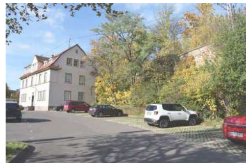
Derzeit von Bäumen und Sträuchern verdeckte Stadtbefestigung
