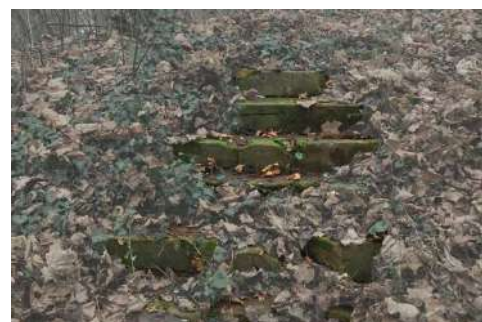
Unter Laub verdeckte Treppenstufen
